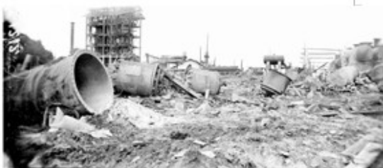
Photo de la poudrerie après l'incendie.
