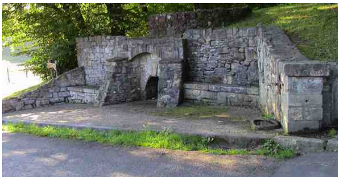
Four à chaud d'Herauritz
