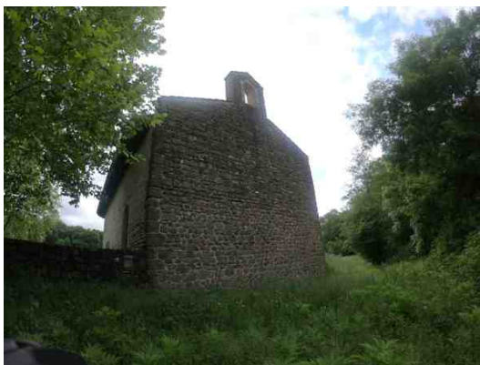
Mur construit avec les pierres récupérées.
